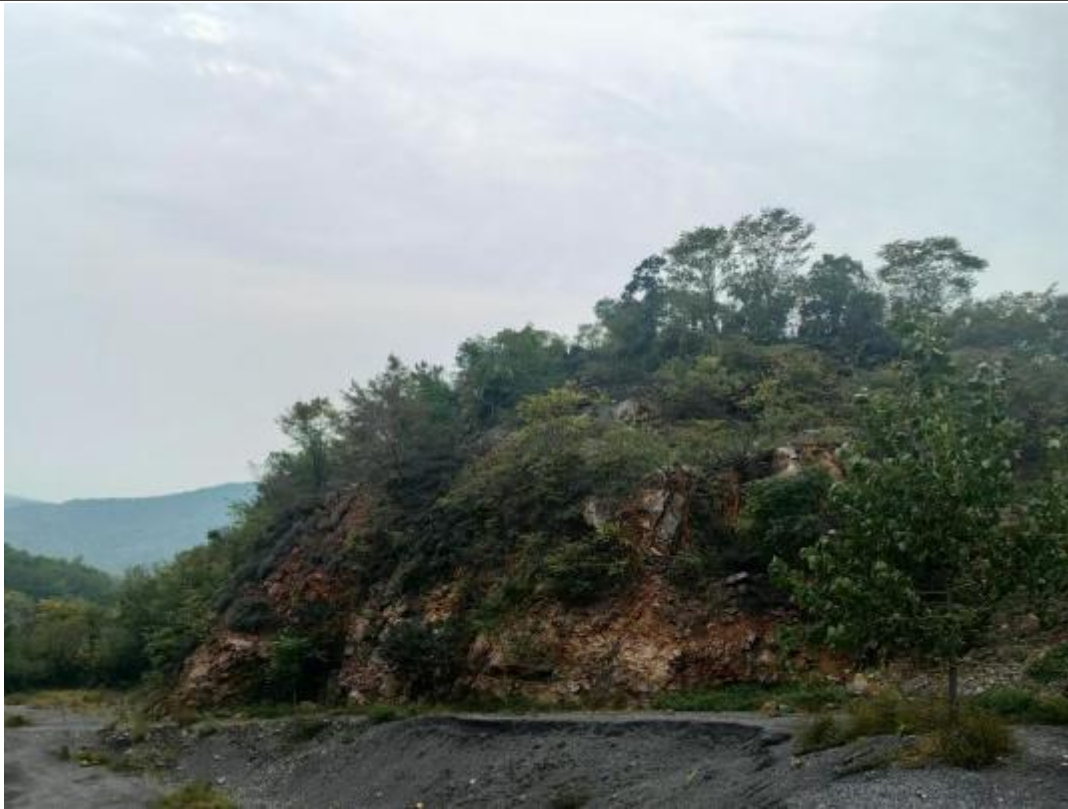
图 3-3 A2 区边坡现状图
